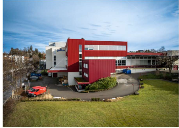
Image: Facility Management à St-Gall à la Harzbüchelstrasse
