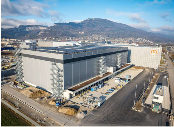
Image: Projet de référence dans l'installation Bell Opera Holinden à Oensingen
