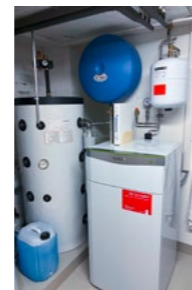
Heizungssanierung Einfamilienhaus Winterthur Hälg & Co. AG Winterthur
