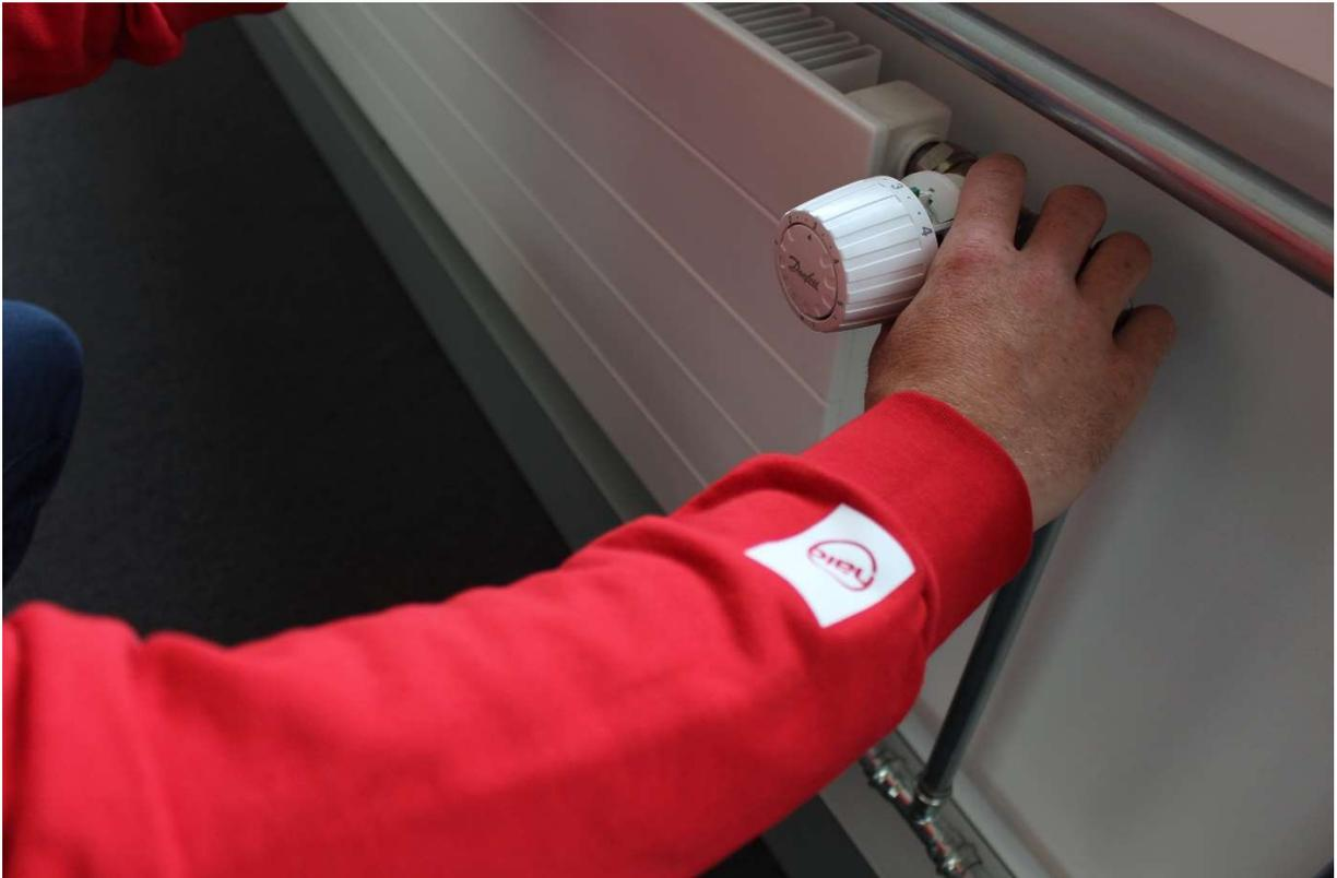
Bildlegende: Installationsarbeiten für den Ersatz eines Thermostaten
